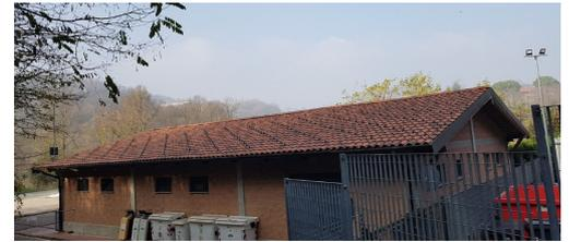
Scuola Elementare: rifacimento guaina e pavimentazione lato ambulatorio, rimaneggiamento coppi rotti, faldali, grondaie e intonaci e tinteggiatura.
