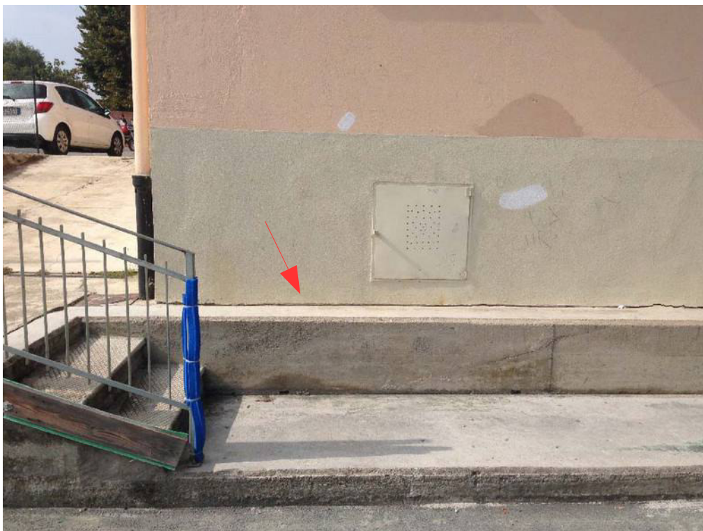
Immagine 16: fessurazione esistente rilevata tra la facciata Est e l'antistante cordolo in cemento (fotografia ripresa da valle verso monte).
