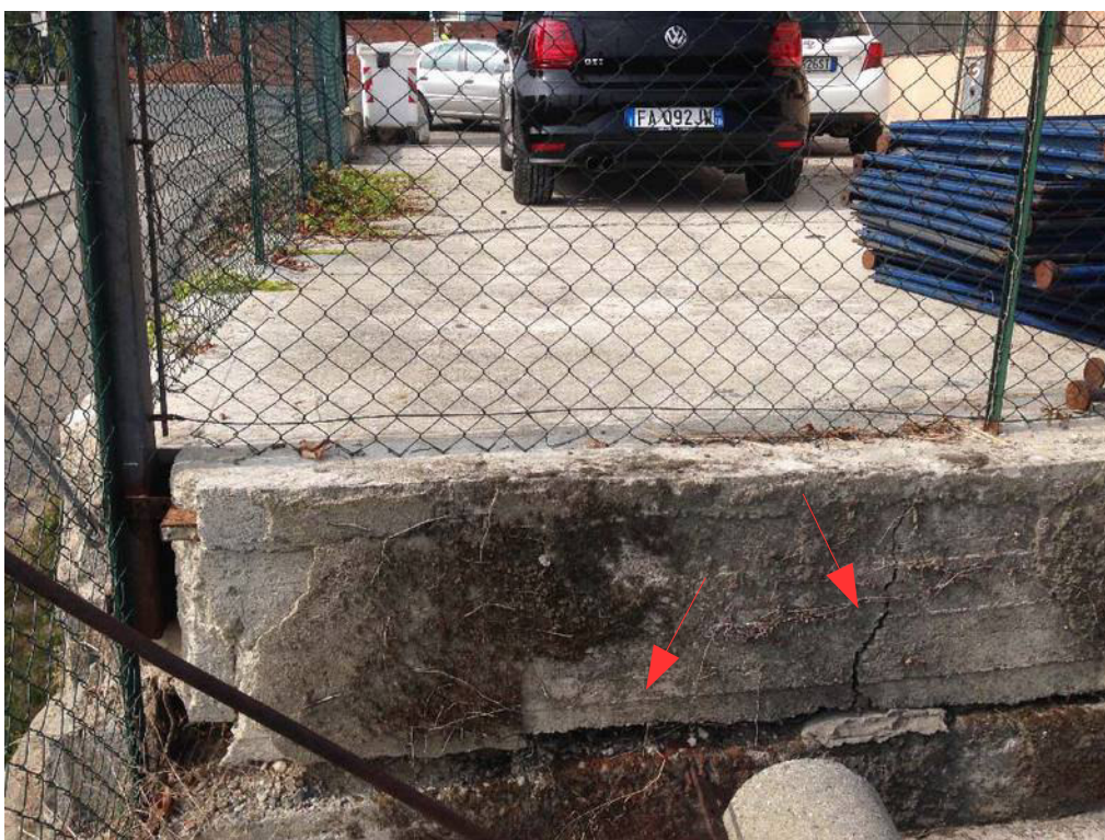
Immagine 17: lesioni esistenti sui manufatti i contenimento del terrapieno (fotografia ripresa da valle verso monte).
