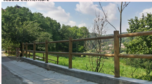
Palizzata realizzata nel mese di aprile (costo di 18.000 euro.). L'amministrazione intende riaprire l'antica strada comunale di Tetti Fantini.
