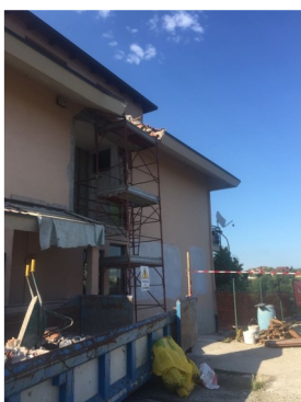
Installazione dell'ascensore scuola elementare
