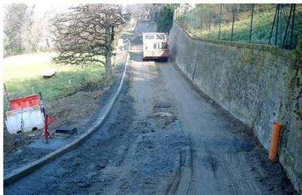
Procedono i lavori di sistemazione e riqualificazione di via del Rubino e strada Tetti Viora. E' stata ultimata la rete fognaria e quella di raccolta delle acque piovane, queste ultime saranno convogliate nel rio delle Boie. Sul bordo verso valle di via del Rubino sono stati collocati cordoli in cemento per il contenimento della sede stradale
