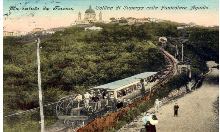
L'antica funicolare Agudio nel tratto di Pian Gambino con la strana motrice teledinamica agganciate alle carrozze tutt'ora utilizzate e l'evidente pilone in muratura ancora oggi esistente, che rinviava e sosteneva la parte superiore del cavo di trasmissione del moto
